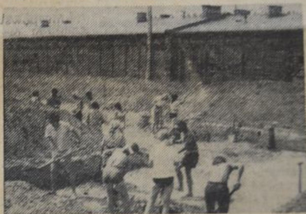
Równoległe z pracami rozbiórkowymi kontynuowane są badania archeologiczne na terenie byłych hoteli. Dotychczasowe wykopaliska potwierdzają istnienie na tym obszarze osad ludzkich zamieszkiwanych przed tysiącami lat. Fot. J. PODLECKI
